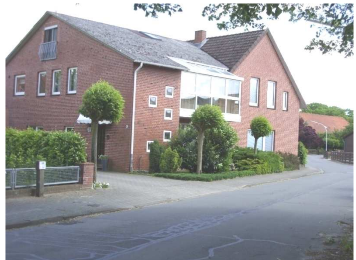
Gebäude der früheren Bäckerei H. Neben in Handorf
