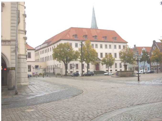
Landgericht mit Gerichtsgefängnis (linker Gebäudeteil)
